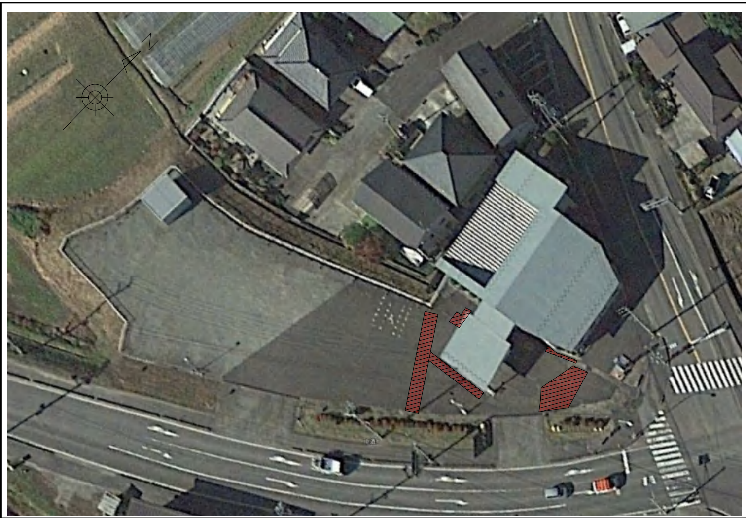
アスファルト補修箇所
